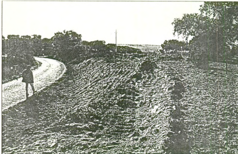
Movimientos de tierra en Ajuda, en la zona portuguesa, por donde se accederá al nuevo puente.
